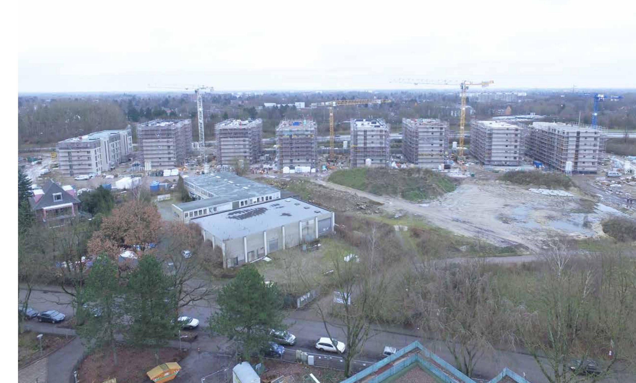
Bau des 1. Abschnitts, im Vordergrund noch die Werkshalle von Süptitz und links die Rotklinkervilla / Süptitz-Villa.
