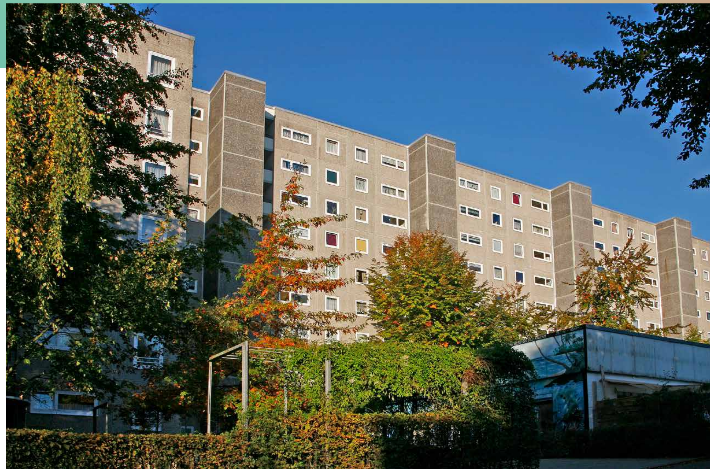
Saga-Hochhaus vom Rebenacker gesehen, vorne das Wichmannhaus.
