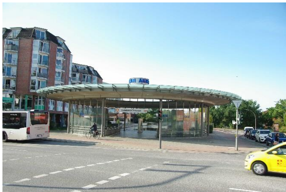
AKN-Station „Eidelstedt Zentrum“
