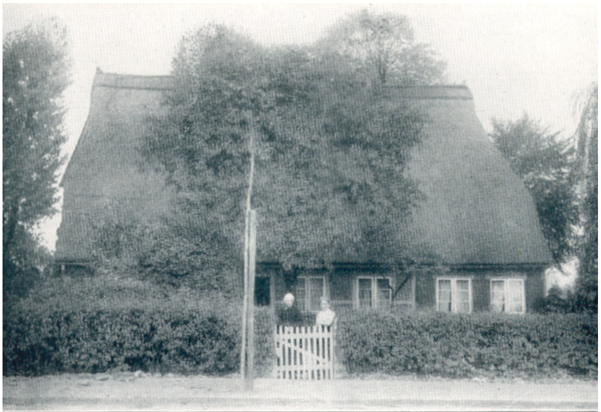
Wohnhaus Fräulein M. Schmidt
